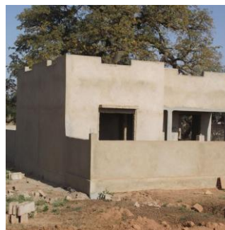
Poste de contrôle phytosanitaire de Koro
