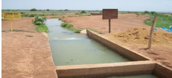
Canal secondaire non revêtu
